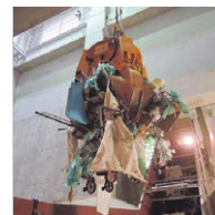
不燃・粗大ごみピット
