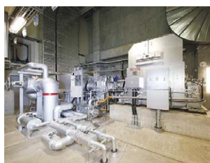
ゴミ発電設備 (蒸気タービン発電機)
